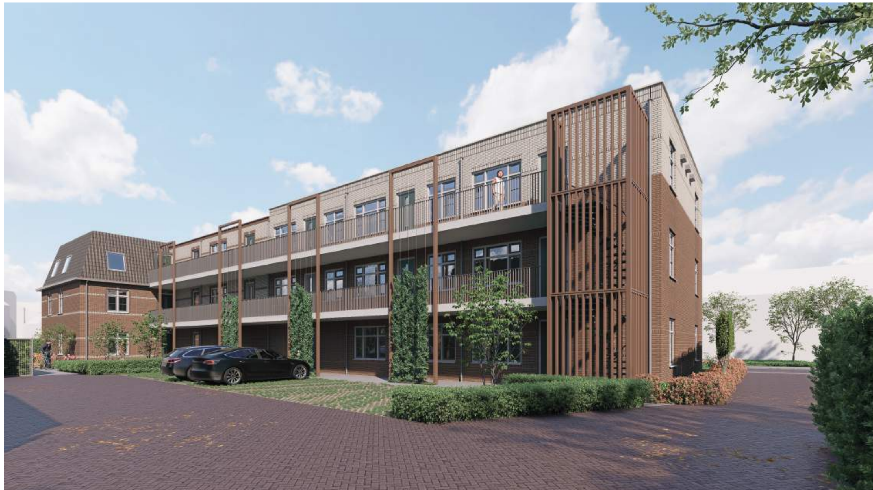
zicht vanaf het binnenterrein
