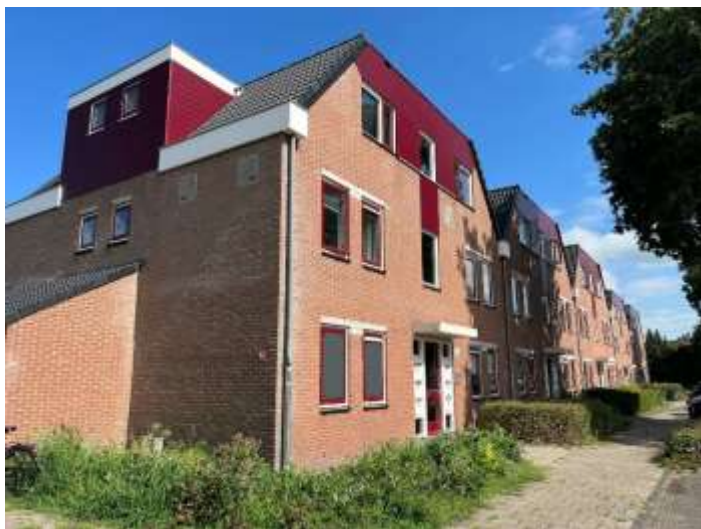
Foto 19: Wooncomplex aan de Krabbescheer, Kortenhoef na dakvernieuwing en onderhoudsbeurt
