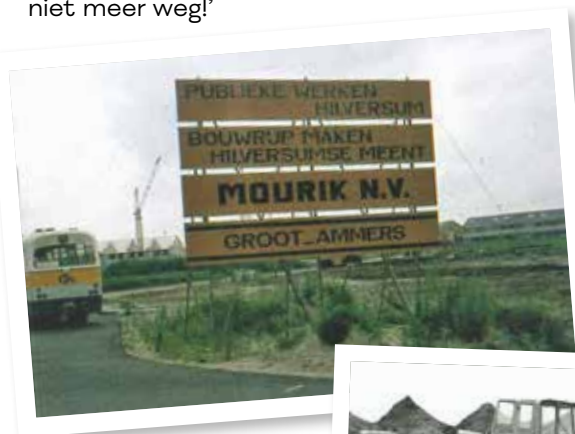
Boven: bouwbord Mourik N.V. Rechts: huurders bekijken de bouwwerkzaamheden.
